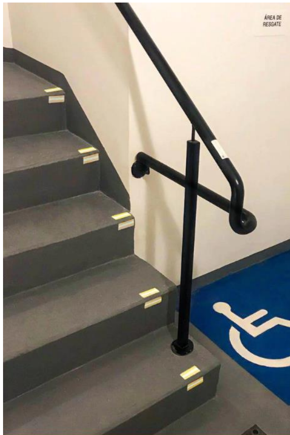
Figura 11 – Faixa fotoluminescente instalada em escada
